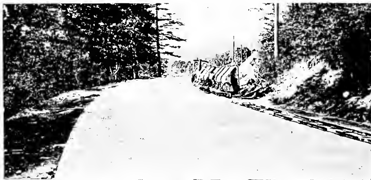
FIG. 62.—Road construction. (U. S. D. A.)
